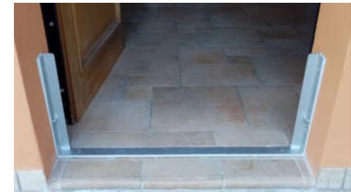
Placa de umbral para alisar la superficie de apoyo de la junta
