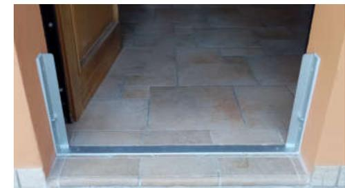
Schwellenplatte zum Glätten der Dichtungsauflagefläche
