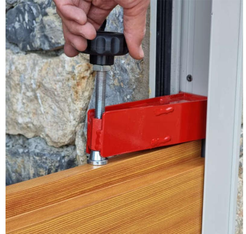
Nachdem der Eingang mit den im Bausatz enthaltenen Führungen vorbereitet wurde, ist es möglich, das Schott sehr einfach zu montieren und zu demontieren, selbst wenn die zu positionierende Barriere sehr groß ist.
