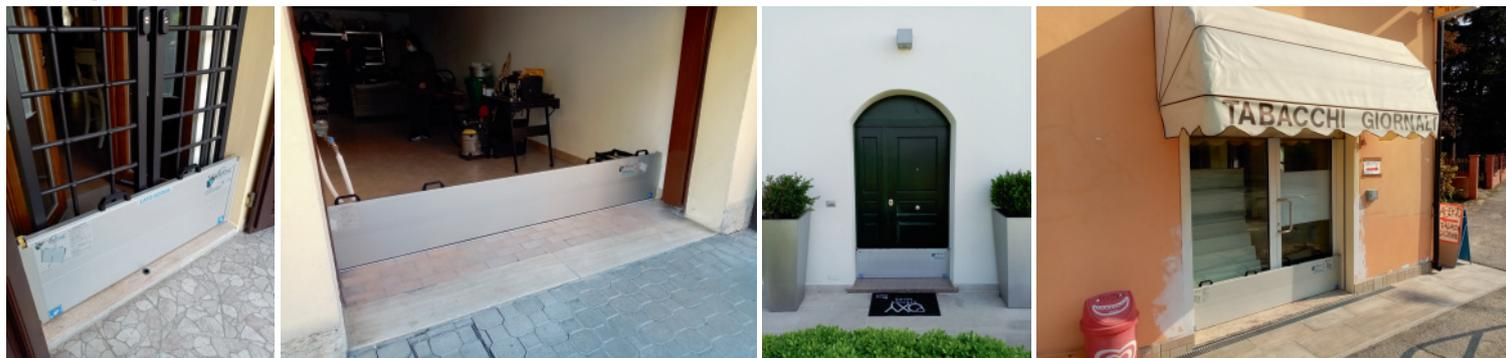
**Montaggio in luce con tubi tipo B**
